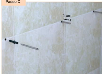
**Insira a bucha** (item 1) do seu kit de instalação que acompanha o produto e **em seguida insira o parafuso** (item 2) **deixando 4 cm** para fora da parede para a fixação do lavatório.
